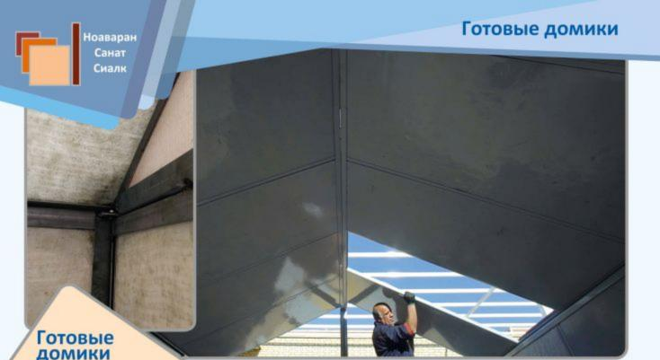
Использование трехмерных композитных панелей на крыше и стенах готовых домиков, помимо простоты транспортировки и установки домиков на много раз, также играет роль тепло-, влаго- и звукоизоляции стен.
