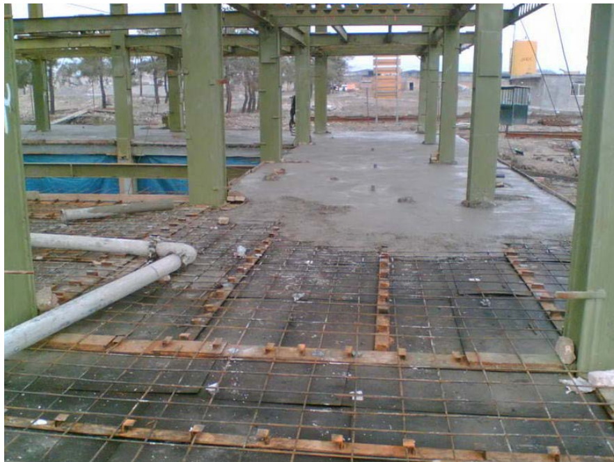
شکل ۹ نمایی از اجرای سقف کامپوزیت
