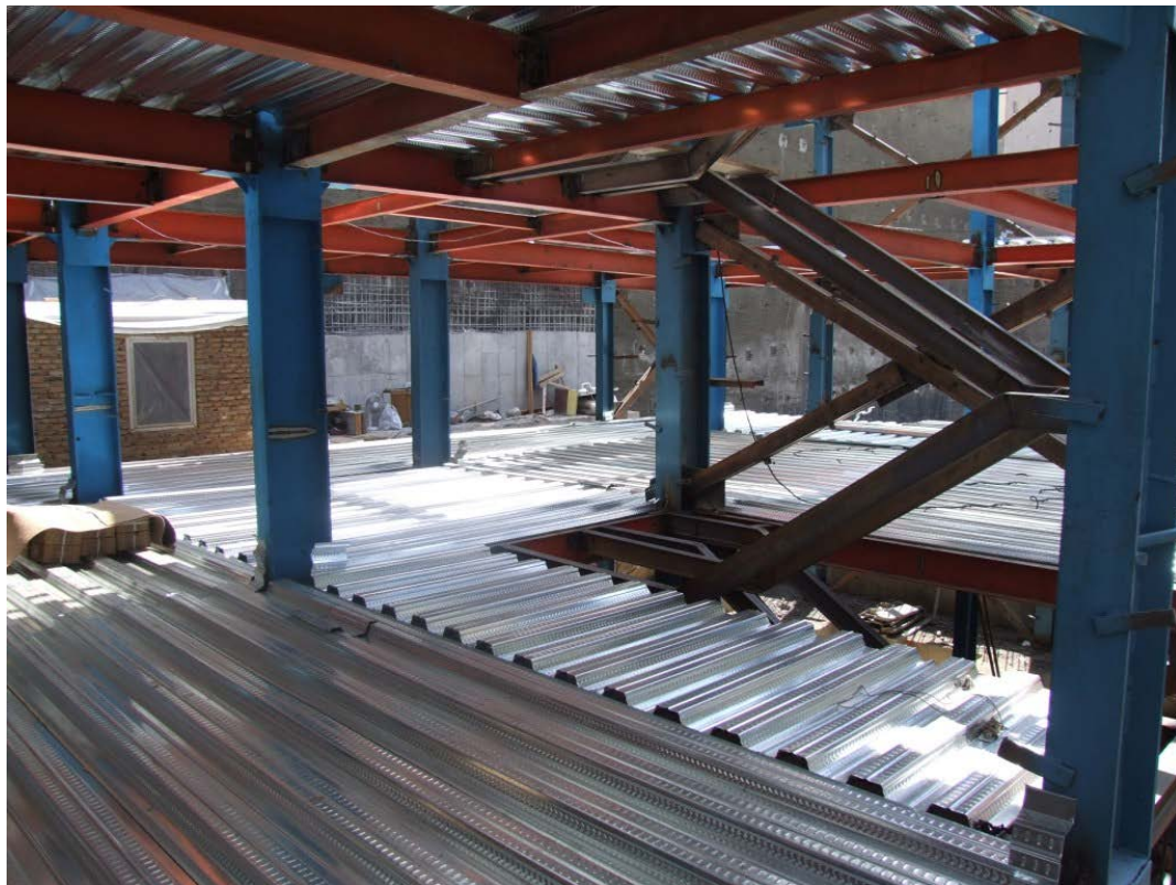
شکل ۱۲ اجرای سقف عرشه فولادی
